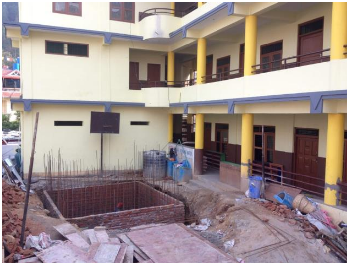
KAISER+KRAFT unterstützt den Bau eines Wassertanks. Quelle: KAISER+KRAFT
