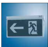
Oprawa oświetleniowa drogi ewakuacyjnej
